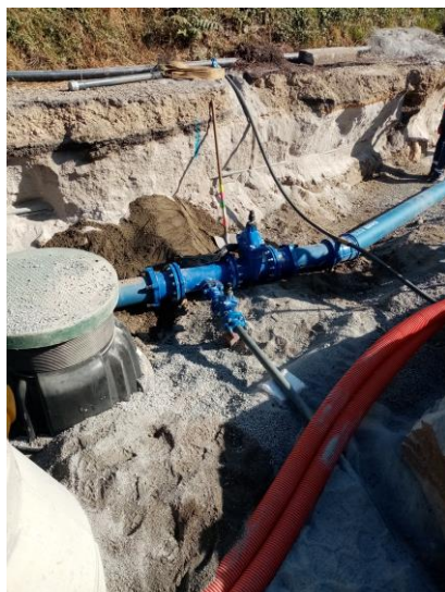
Chantier rue Tour du Génie à Ploemeur
