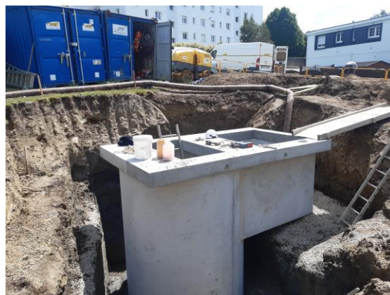
Travaux sur Poste de relevage Geoffroy à Lanester
