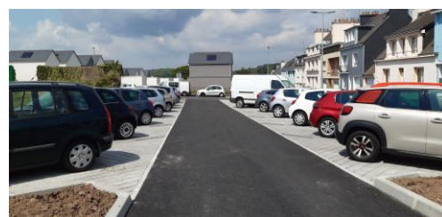
Parking drainant rue G. Philippe à Lanester
