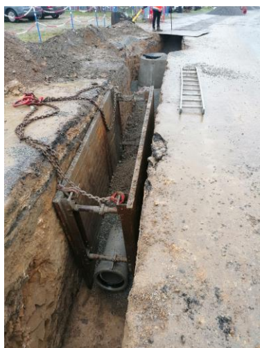
Travaux réseaux eaux pluviales, Kerandré à Hennebont
