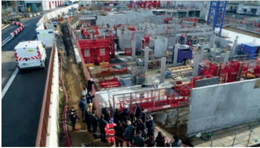
Novembre 2018 - pose de la première pierre du programme immobilier Eolie, livré au printemps 2020.
