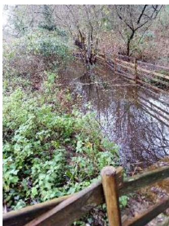
Rive droite amont buse ; le 30/12
