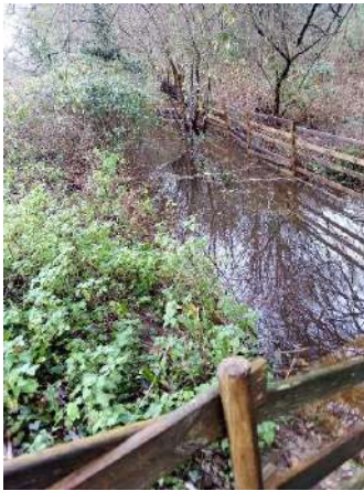
Rive droite amont buse ; le 30/12
