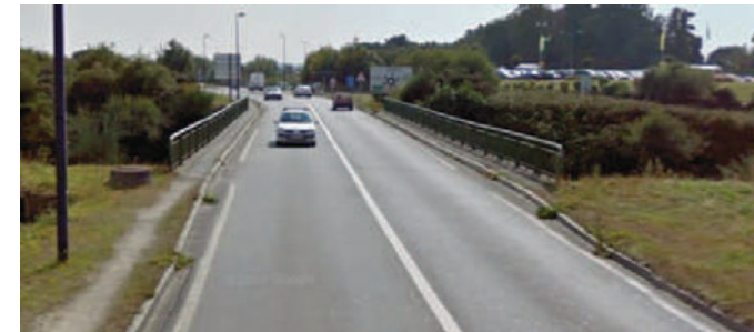
D163 entre le Mourillon et Quéven. Les pratiques existantes à en croire le cheminement tracé par les piétons mais les conditions de sécurité sont critiques (et de toute façon hors des critères d'accessibilité).
