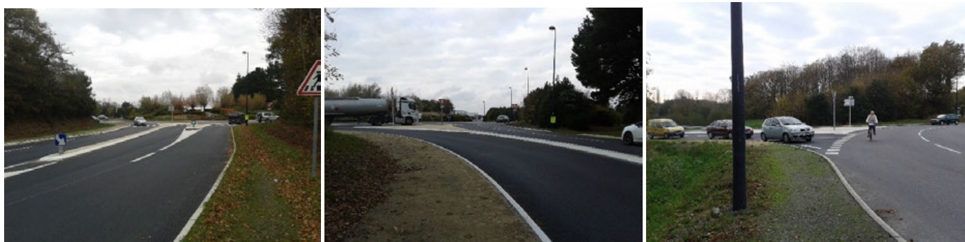
Élargissement et doublement de voies au niveau du rond-point du Mourillon (photographies : ECR, novembre 2015)
