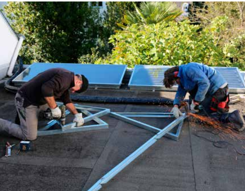
Sur un chantier de pose de panneaux solaires thermiques.
