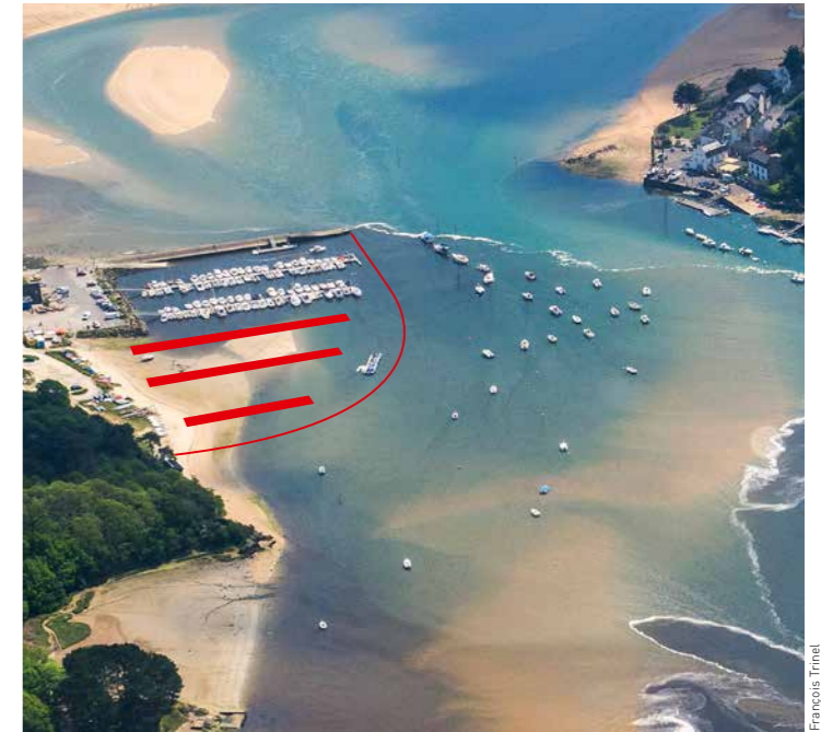
Le projet d'extension du port de Guidel
