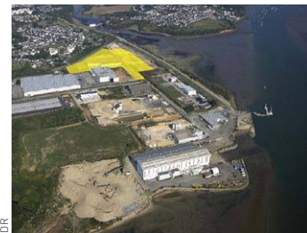
Capitaine Houat (en jaune sur la photo) occupe désormais 17 000 m 2 sur la zone du Rohu, à Lanester.
